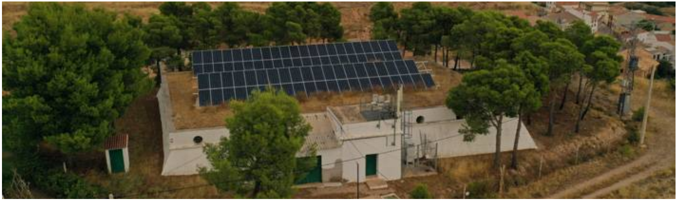
Bombeo solar sobre depósito municipal de Albalate del Arzobispo
