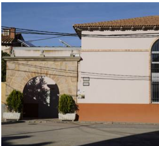
Placas solares en Torrelacarcel
