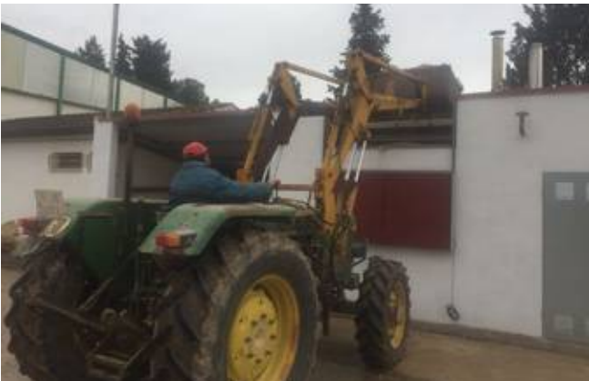
Cargando la caldera de biomasa de olivera
