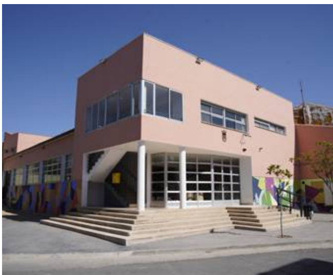
Pabellón de Fuentes Claras
